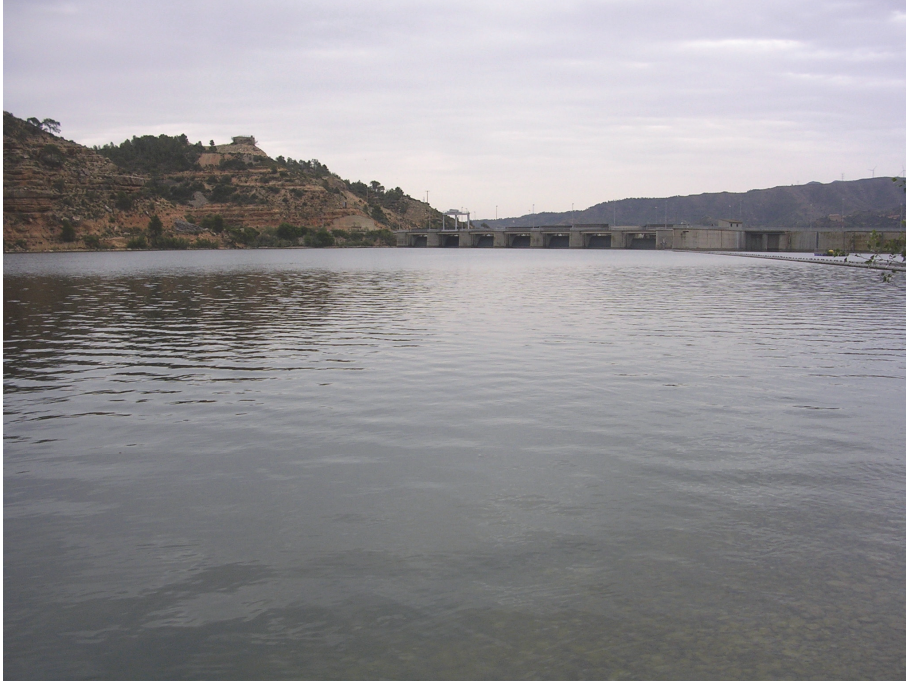
Figura 7: Presa del embalse
