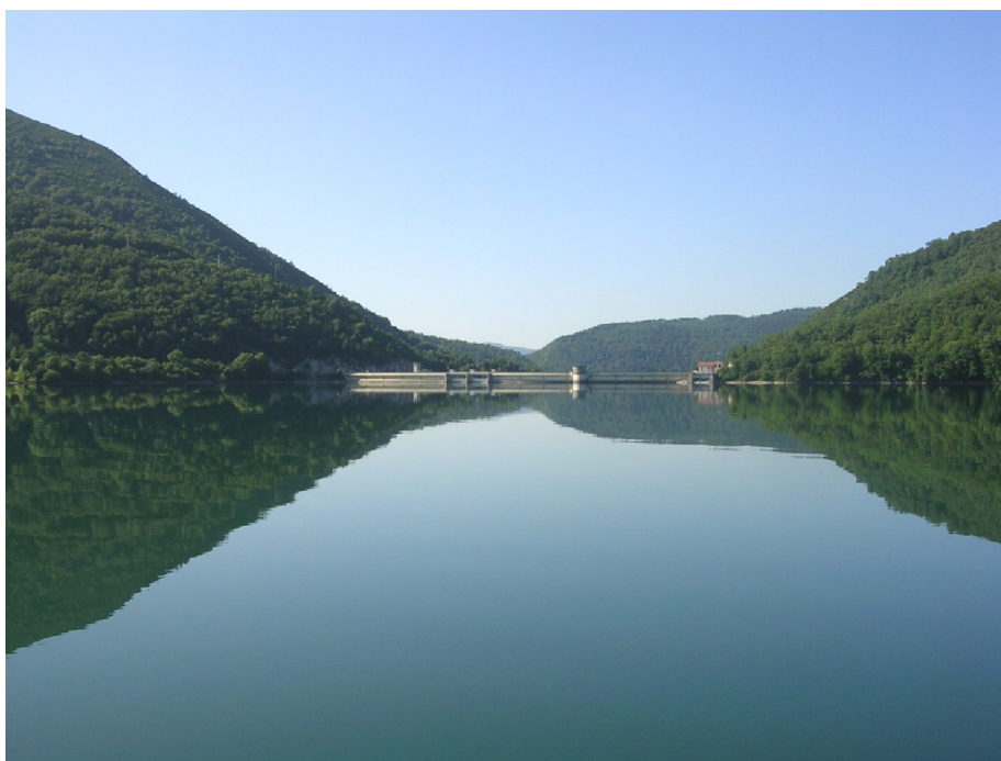
Figura 7. Vista de la presa del embalse
