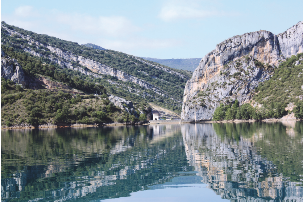
Figura 7: Presa del embalse de Barasona
