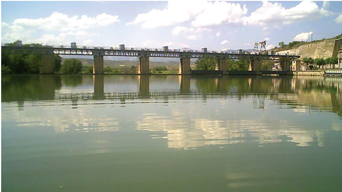
Foto 1: Vista de la presa del embalse desde el punto de acceso
