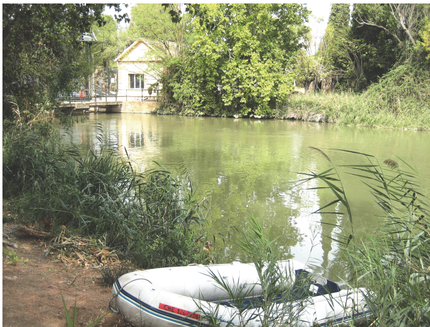
Foto 1: Vista de la presa desde el punto de acceso
