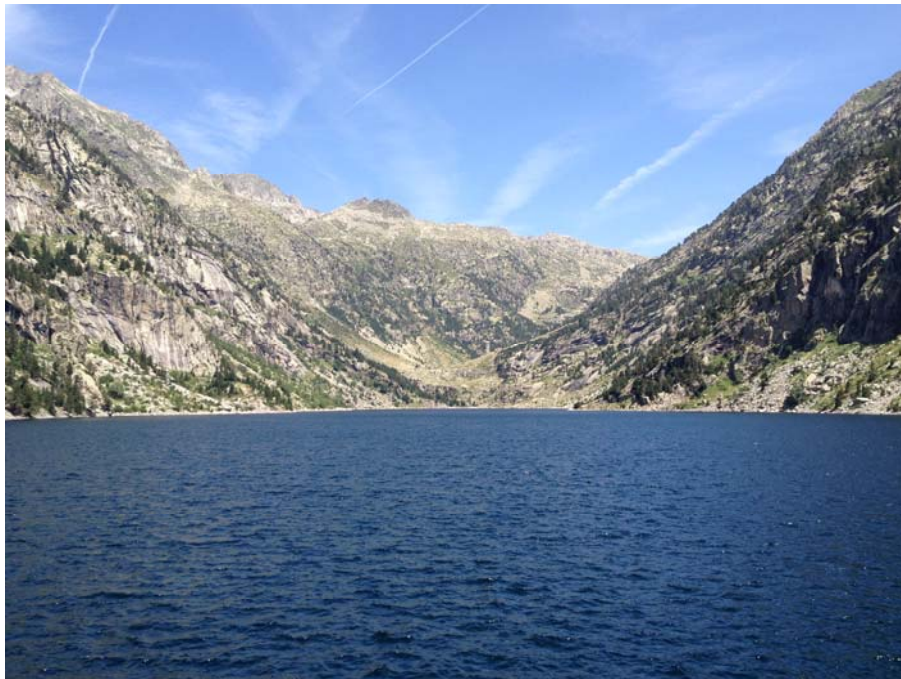
Figura 6. Vista de la cola del embalse
