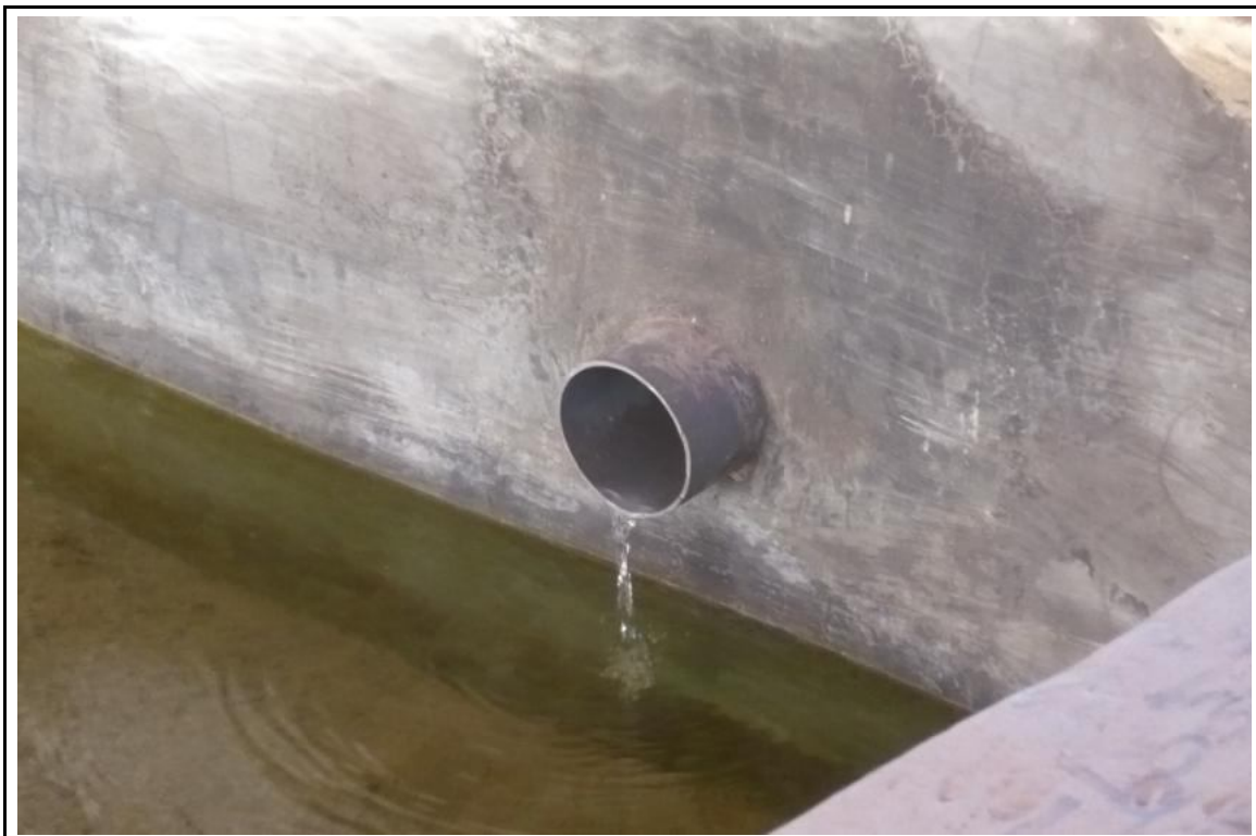
Detalle del punto de toma (10/11/2008)
