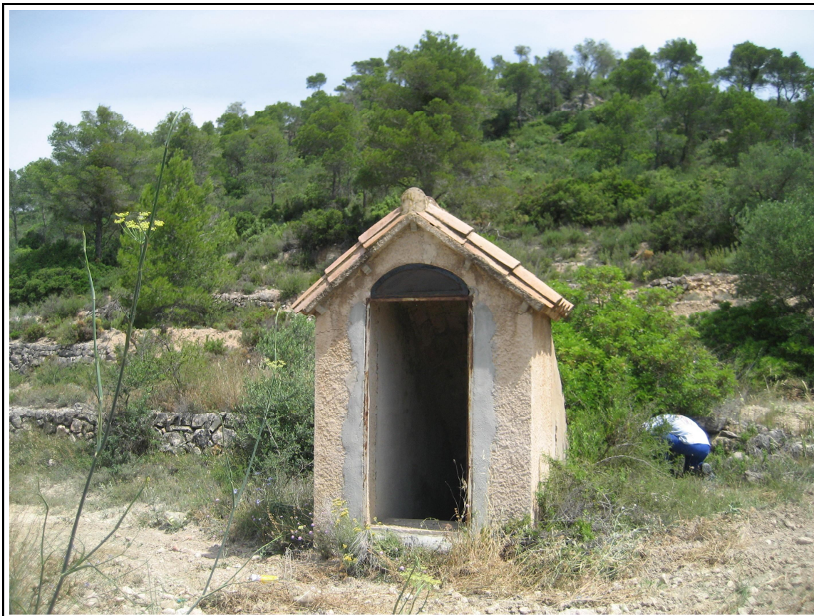
Caseta del manantial Aguas de Broi (08/07/2008)
