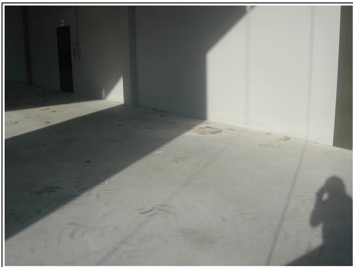
General del pozo (14/11/2006)
