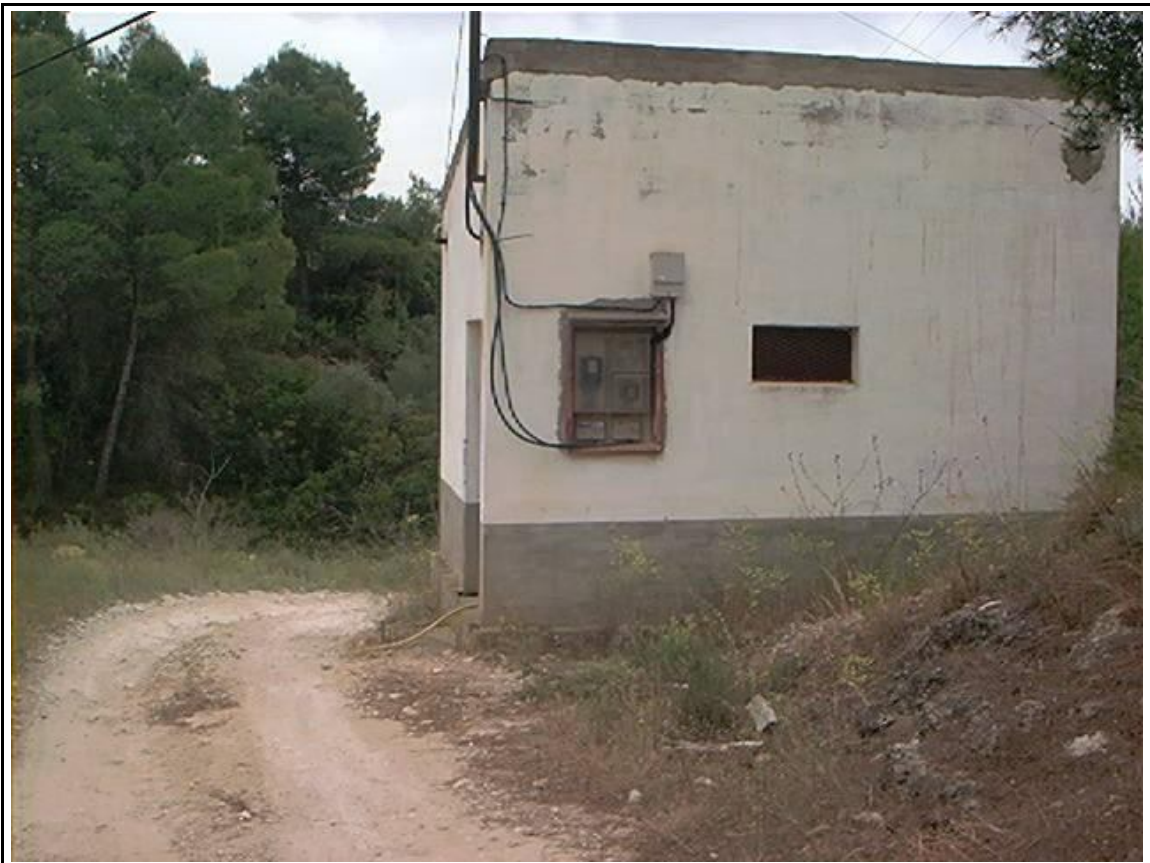
FOTO RED CONTROL NITRATOS. VISTA DE LA CASETA DEL POZO (03/06/2002)
