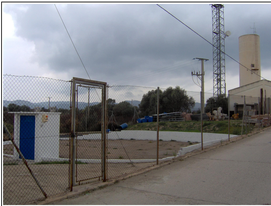
Depósito subterráneo de Mora La Nova (16/11/2006)
