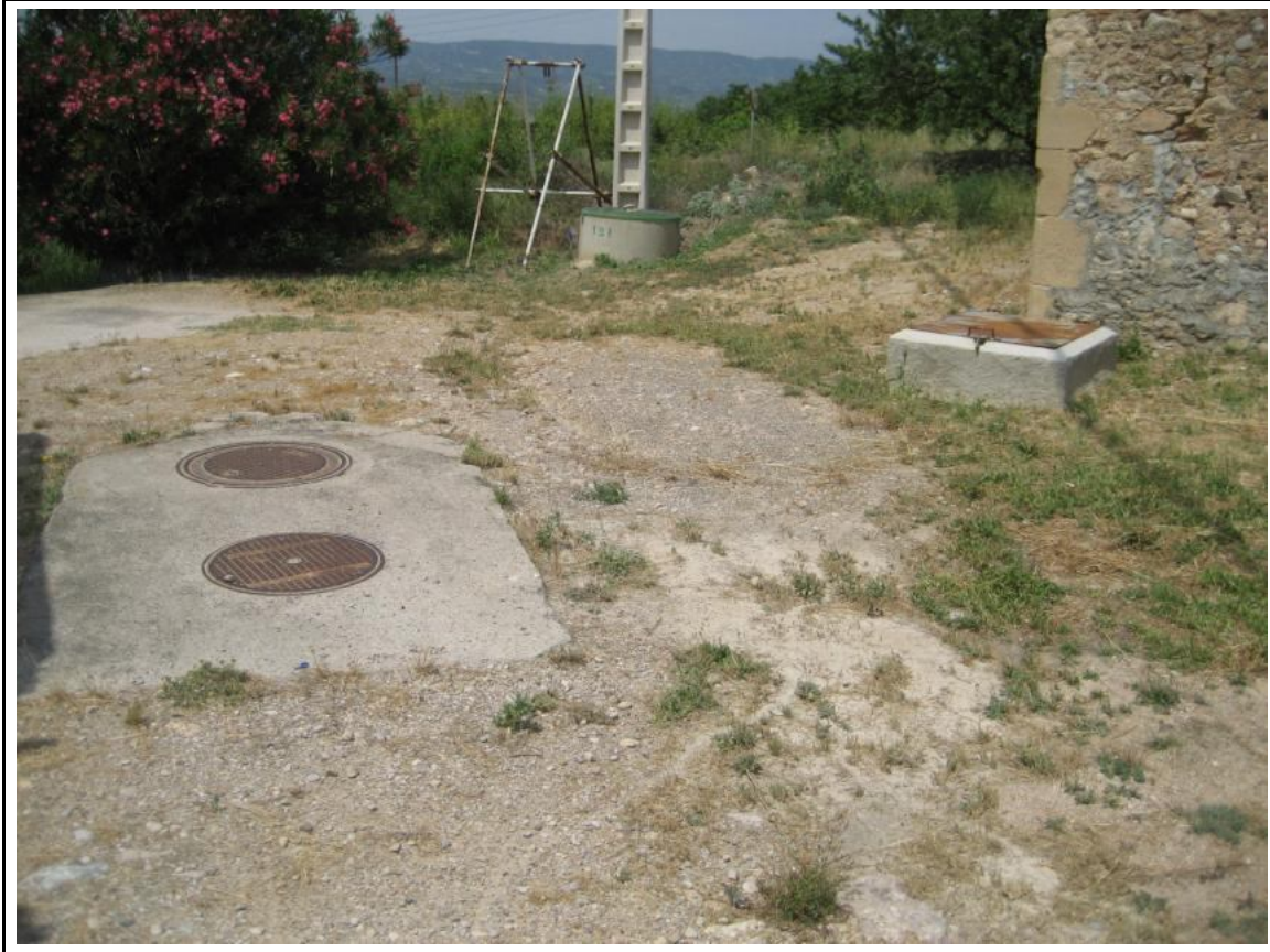
Arqueta del pozo del lavadero de la Torre de l'Espanyol (08/07/2008)
