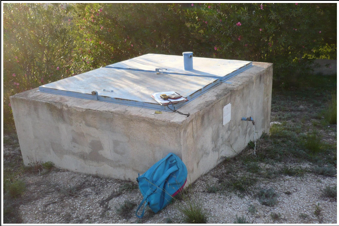
Vista general de la captaci3n (09/11/2008)
