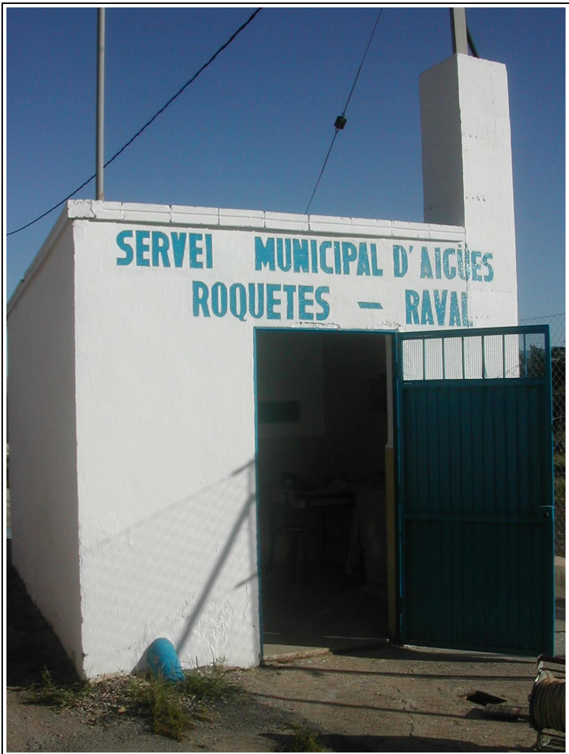
Caseta de captación (14/11/2006)
