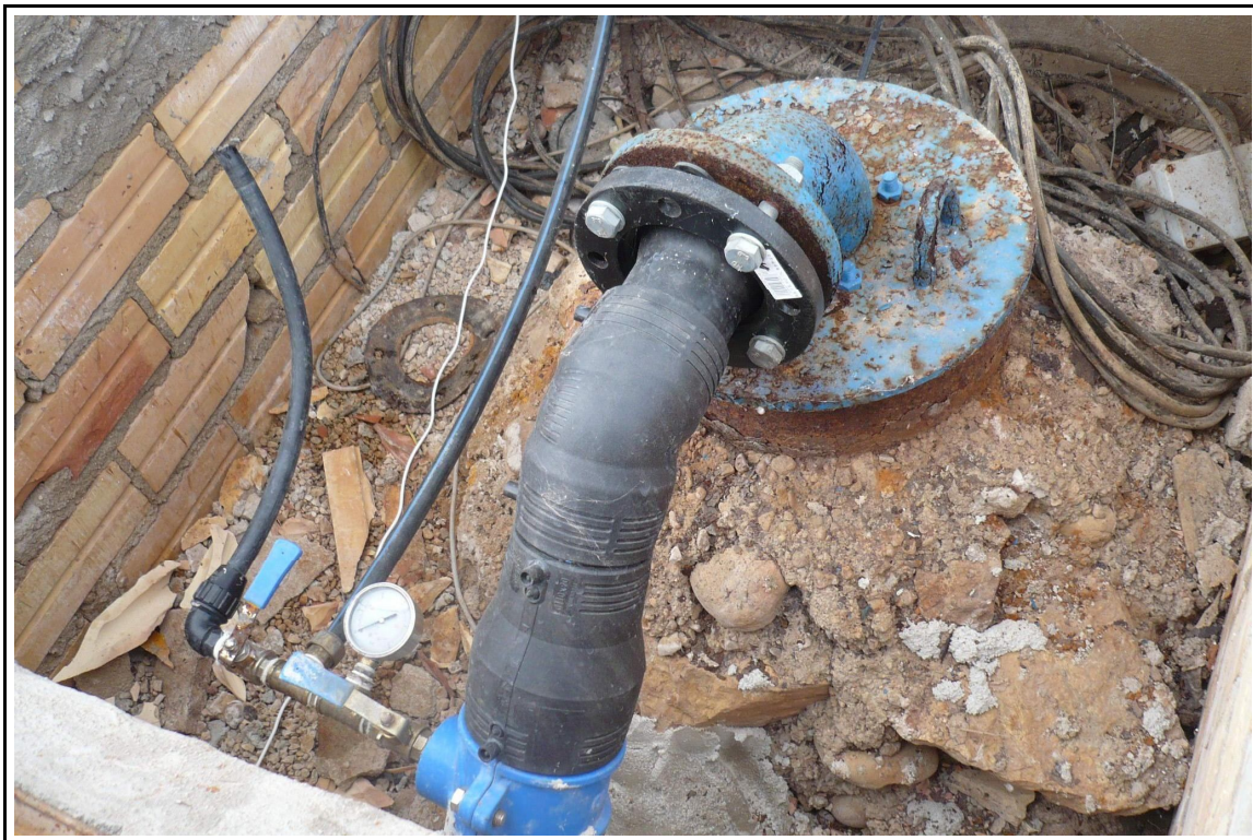
Detalle Del Pozo 1 (04/05/2009)
