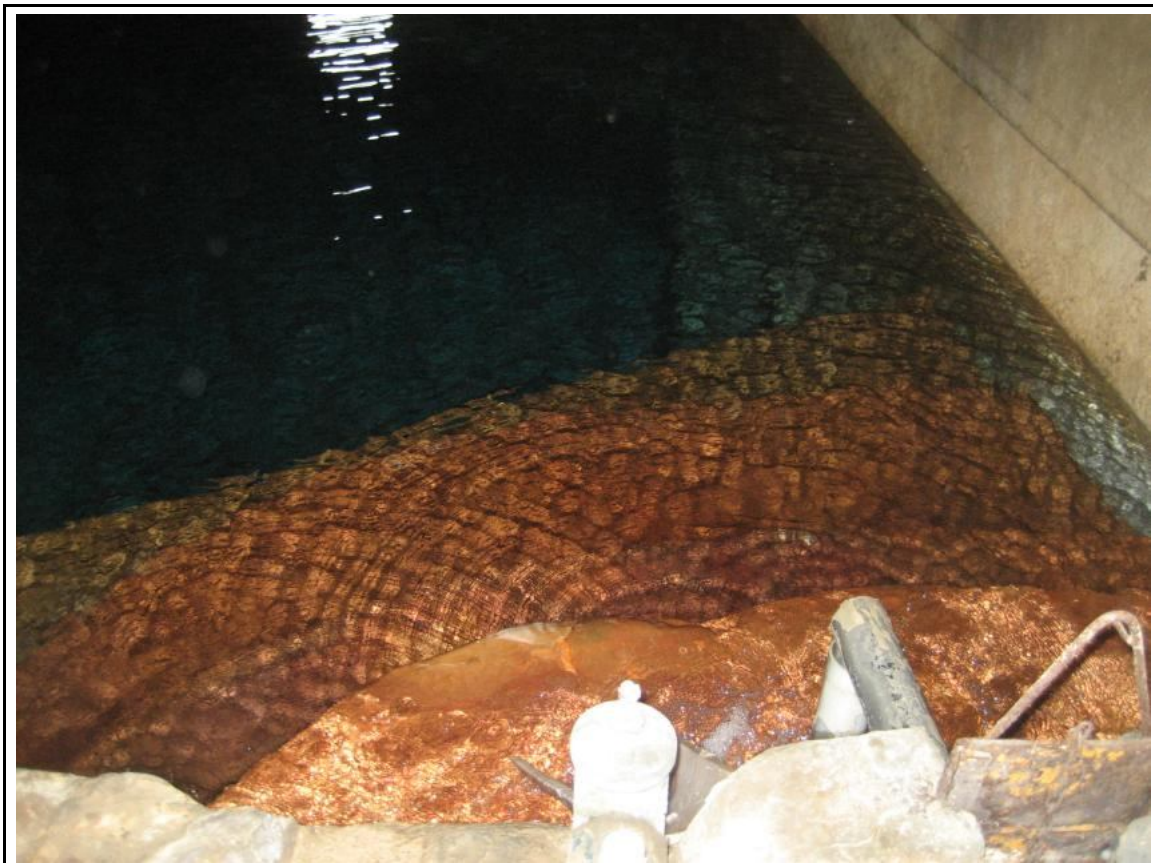
Interior balsa - depósito (08/07/2008)
