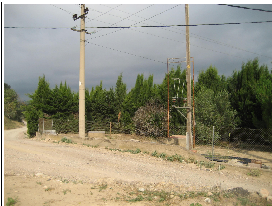
Situación de l pozo S orts (09/07/2008)
