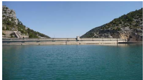
Foto 3: Presa del embalse de Pena
