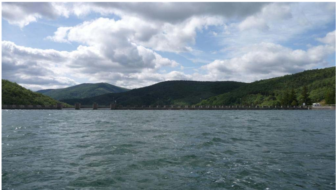
Foto 2: Presa del embalse de Ortigosa
