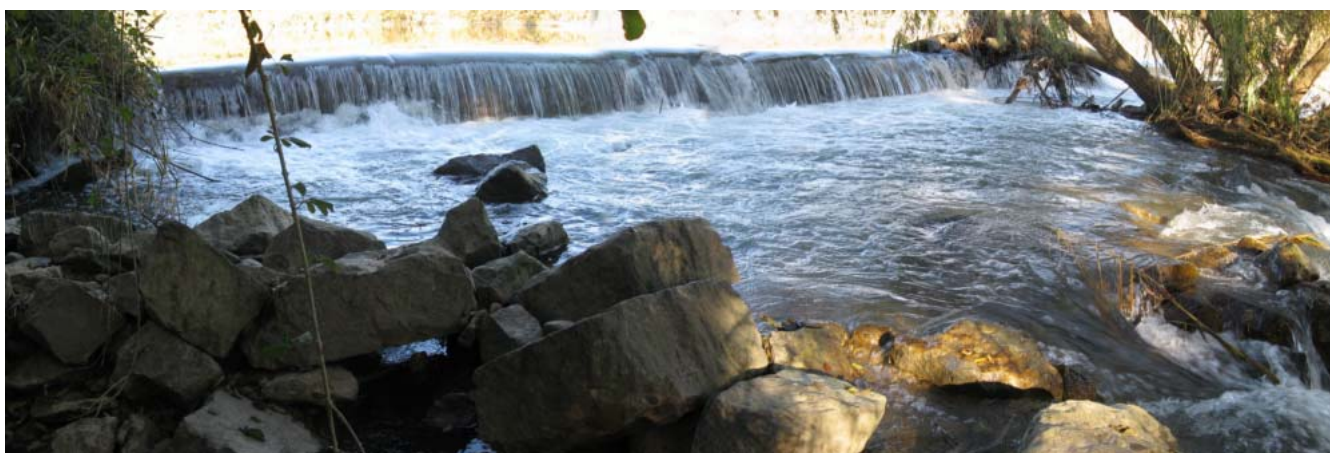
Fig. 5. Vista de la estructura desde la margen derecha del río Alcanadre.
