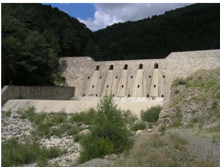
Presa de retención de sedimentos en el barranco de Arás en Biescas. Foto: Alfredo Ollero.
