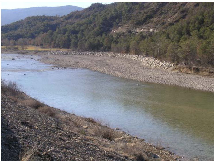
Otra escollera que aparentemente no protege ningún bien, acompañada de dragado del cauce en el río Guarga cerca de Arraso. Foto: Alfredo Ollero.
