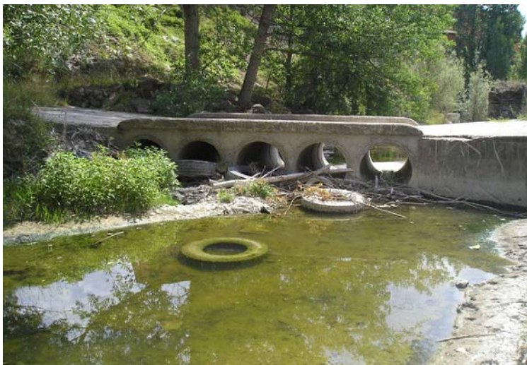
Puente-vado de tubos con retención de sedimentos en el río Tulivana, afluente del Gállego, en Sabiñánigo. Foto: Alfredo Ollero.
