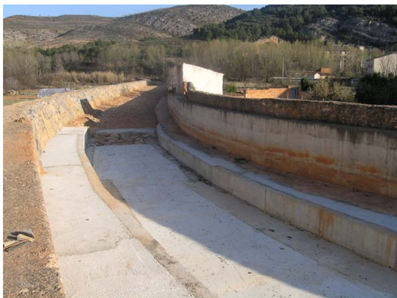
Las canalizaciones totales modifican tanto el fondo como las márgenes. Rambla de Jaraba, afluente del río Mesa. Foto: Alfredo Ollero.
