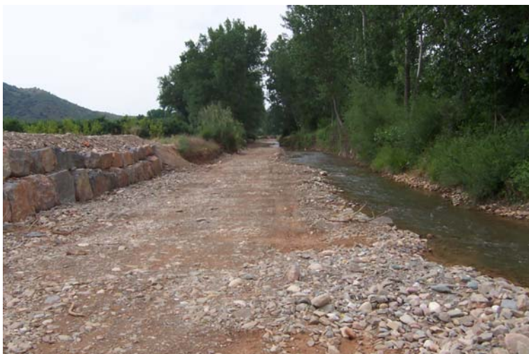
Actuación convencional en el río Manubles en Moros (dragado, limpieza de vegetación y colocación de escollera) implicando un notable deterioro del sistema fluvial. Foto: Noelia Sánchez.
