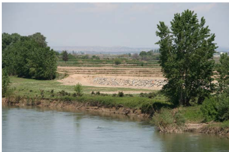
Ruptura de continuidad en el corredor ribereño con deforestación y mota protegida por escollera para salvaguardar los cultivos. Río Ebro en Castejón. Foto: Alfredo Ollero.
