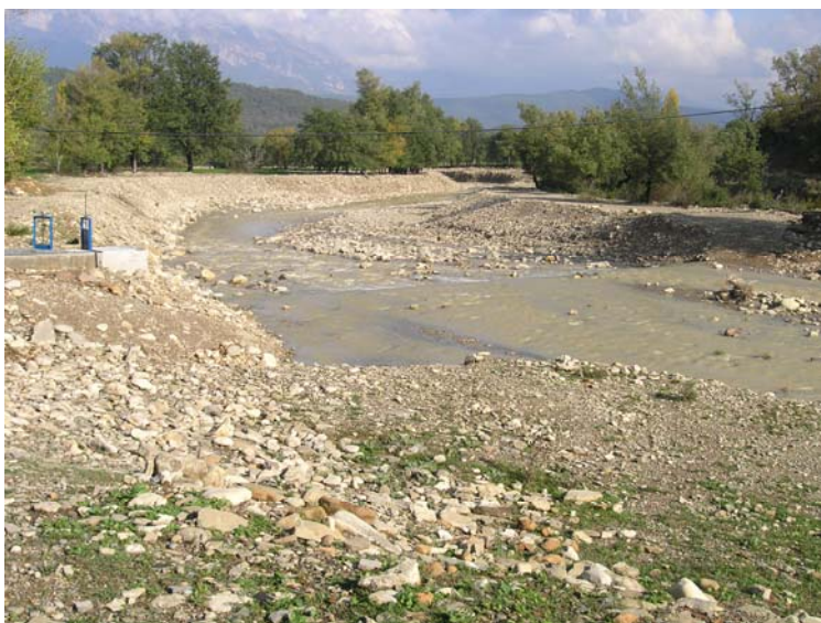
Fondo del lecho del río Sieste (cuenca del Cinca) destruido por un dragado, actuación “de urgencia” tras la crecida de julio de 2001. Foto: Alfredo Ollero.
