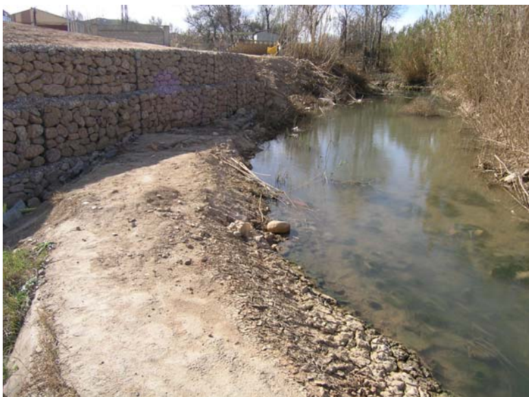
Defensa de gaviones y muy deficiente estado del cauce en Cuarte de Huerva. Foto: Alfredo Ollero.
