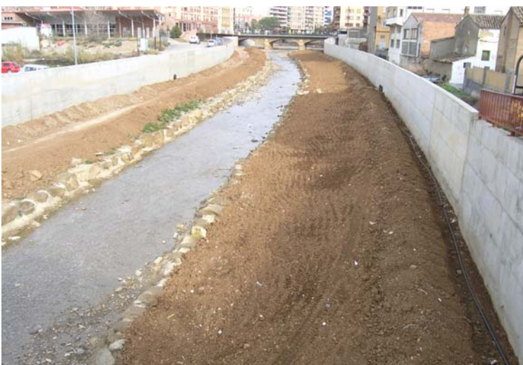
Canalización del río Sosa en Monzón. Además de levantar muros de protección se ha fijado el cauce menor con escollera hormigonada. Foto: Alfredo Ollero.
