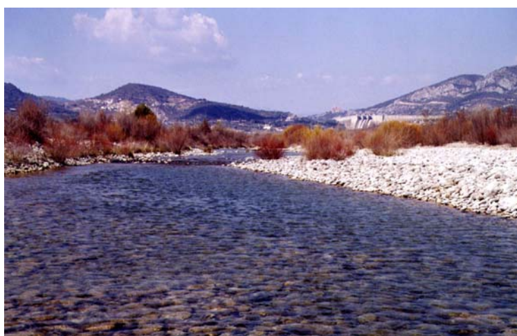
El río Cinca al pie de la presa de El Grado sufre un notable proceso de incisión que ha favorecido la matorralización de la ribera, como puede observarse en la foto. También es visible el cubrimiento de algas y finos en los cantos del lecho, debidos a la escasez de caudales, incapaces de movilizar los sedimentos. Foto: Ana Sáenz de Olazagoitia.
