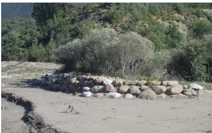
Escollera construida con bloques extraídos del propio cauce en el río Basa, afluente del Gállego, rodeando unos saucos naturales. Foto: Alfredo Ollero.
