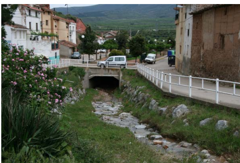
Escollerado y entubamiento bajo el paseo urbano del barranco Yasa Valera, afluente del Cidacos, en Herce. Foto: Alfredo Ollero.
