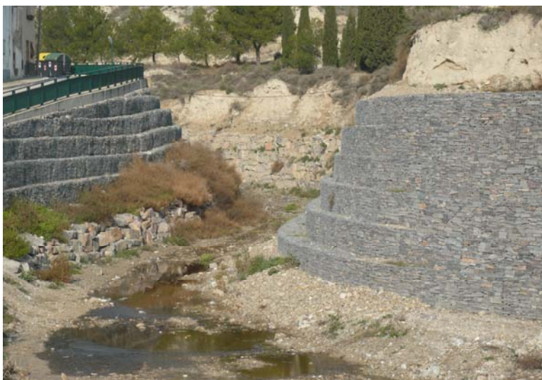
Encauzamiento con escollera y gaviones del barranco de los Lecheros en Alfocea (Zaragoza). Foto: Alfredo Ollero.
