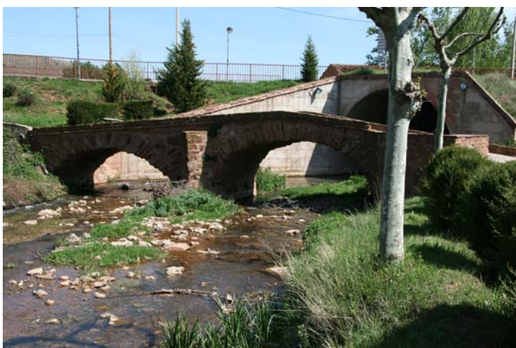
En ocasiones los puentes se suceden en tramos muy cortos produciendo efectos sinérgicos. Río Aranda en Illueca. Foto: Alfredo Ollero.
