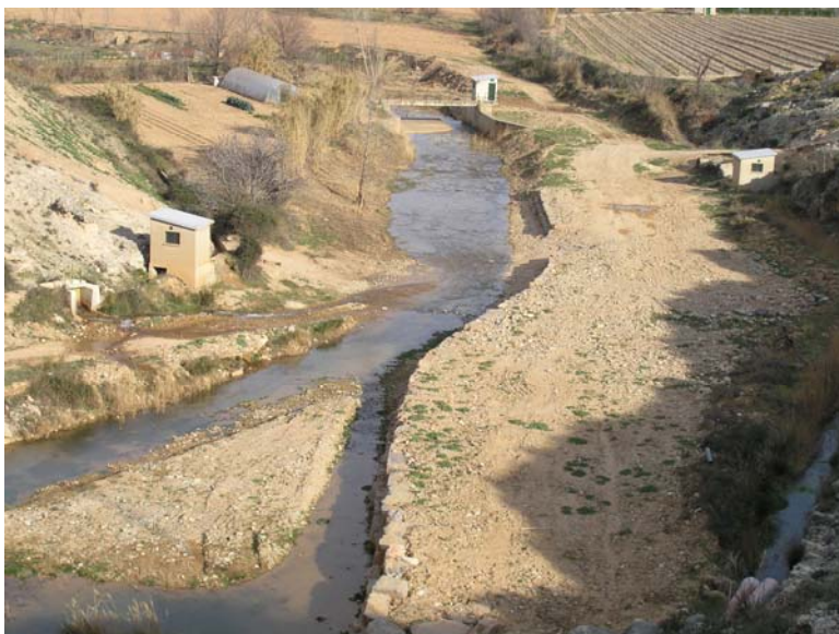
Modificación de la margen derecha del cauce entre la presa de Mezalocha y la estación de aforo. Foto: Alfredo Ollero
