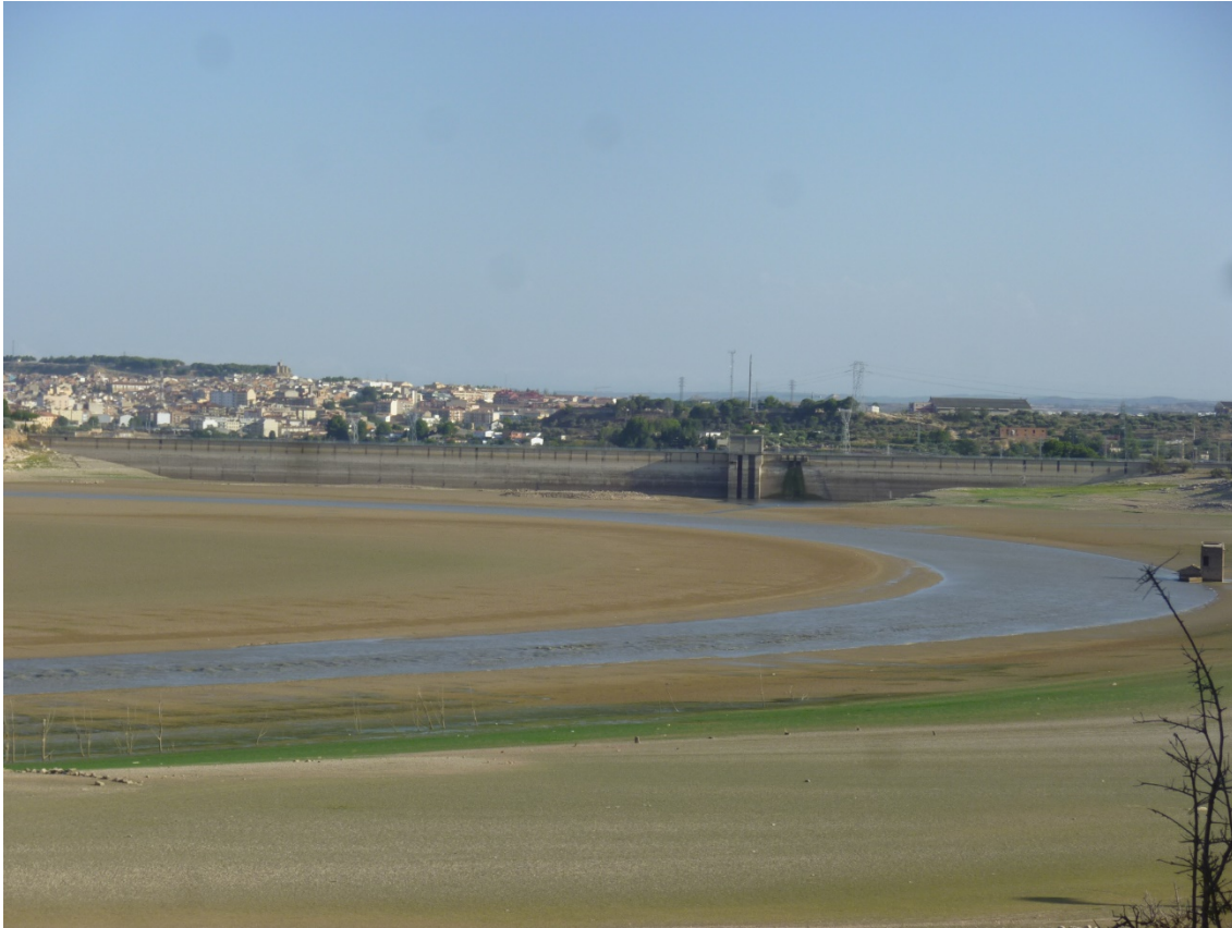
Figura 3.33. Vista de la cola del vaso de Mequinenza: Zona de Caspe. 29/908/2011. Fuente: CHE.
