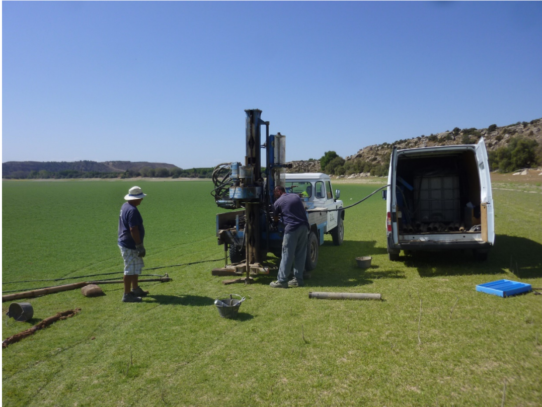
Figura 3.31. Vistas de la cola del vaso de Mequinenza: Sondeo en playas de Chacón. 29/08/2011. Fuente: CHE..
