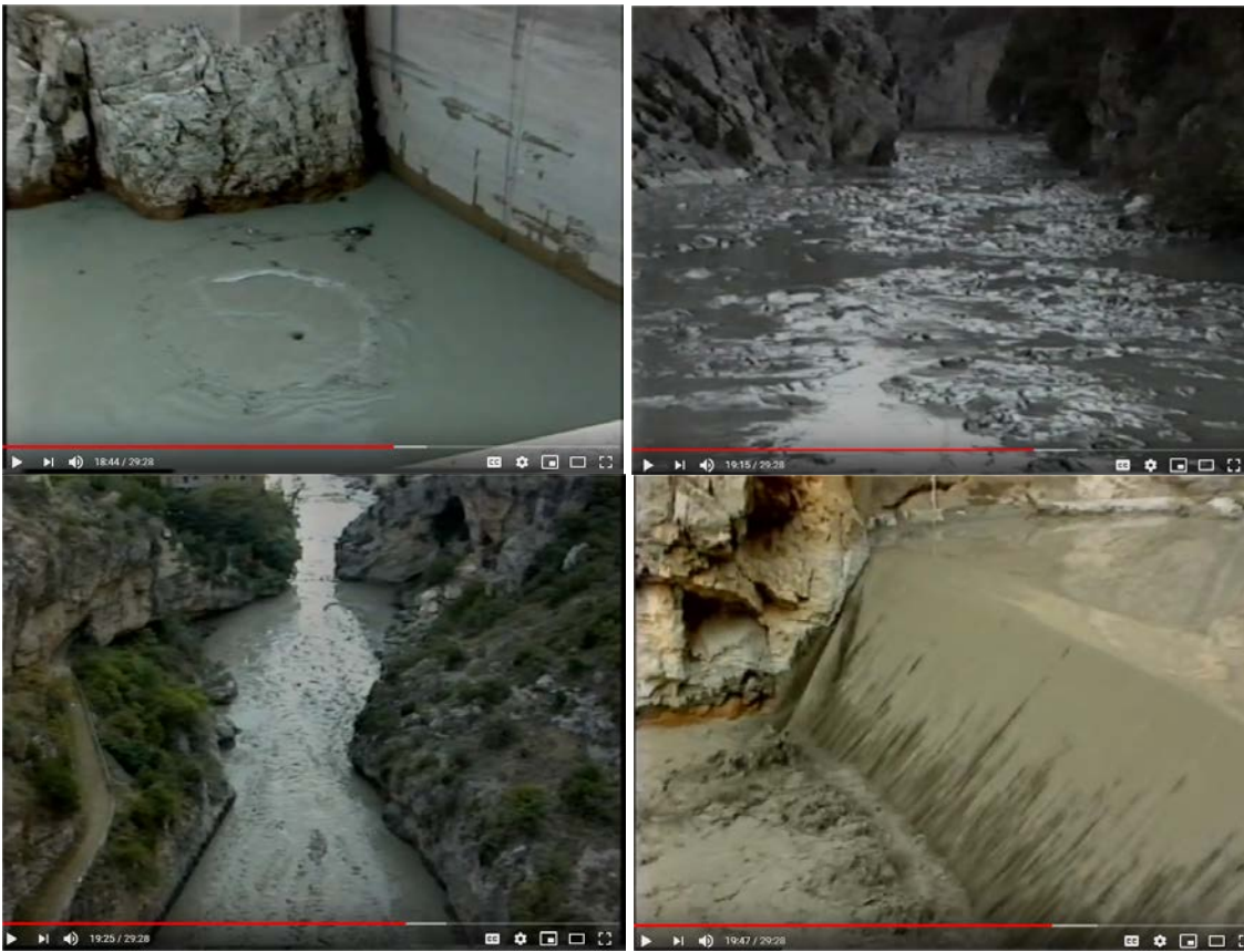
Figura 5.13. Fotogramas del vídeo producido por CHE (1995) sobre el primer vaciado de Barasona, donde se aprecia la concentración de sedimentos.
