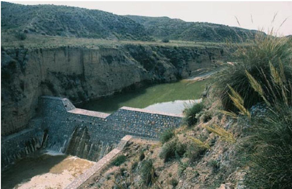
Figura 4.2. Dique de retención de sedimentos en Santa Cruz de la Zarza (Toledo). Fuente Ministerio de Agricultura, Pesca y Alimentación.
