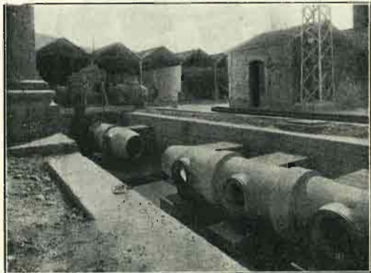
Colector de 1,00 m. con insertos de 0,60 m. — Presión 12 Kg./cm. 2
