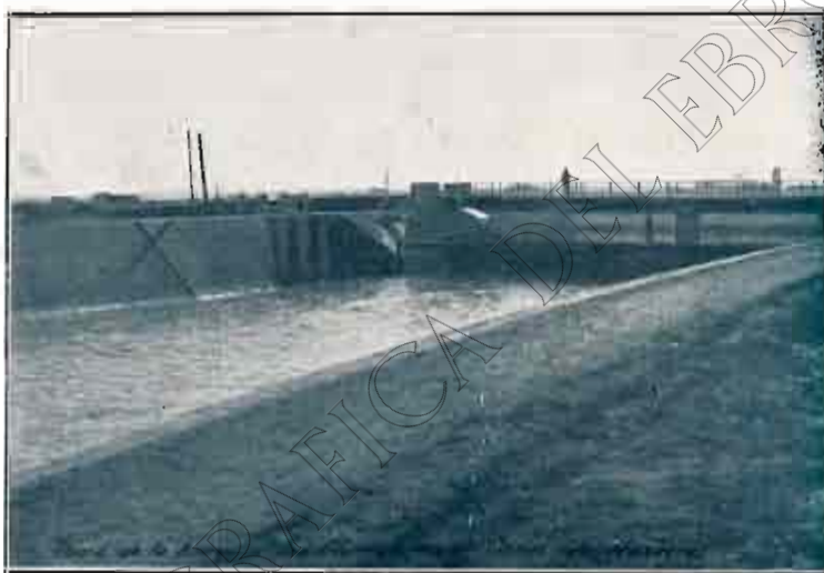
TOMA DE LA ACEQUIA DEL FLUMEN EN EL CANAL DE MONEGROS
