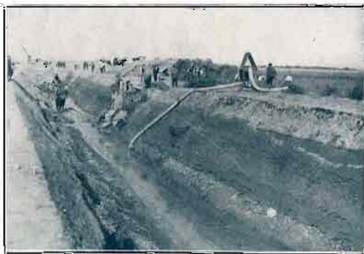
UN ASPECTO DE LOS TRABAJOS DE ENSANCHE DE LA VIEJA ACEQUIA DE FUENTES. EN PRIMER TÉRMINO, LA PARTE DEMARCADA
