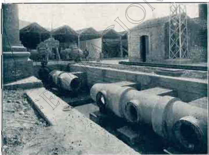
Colector de 1,00 m. con injertos de 0,60 m. — Presión 12 Kg./cm. 2
