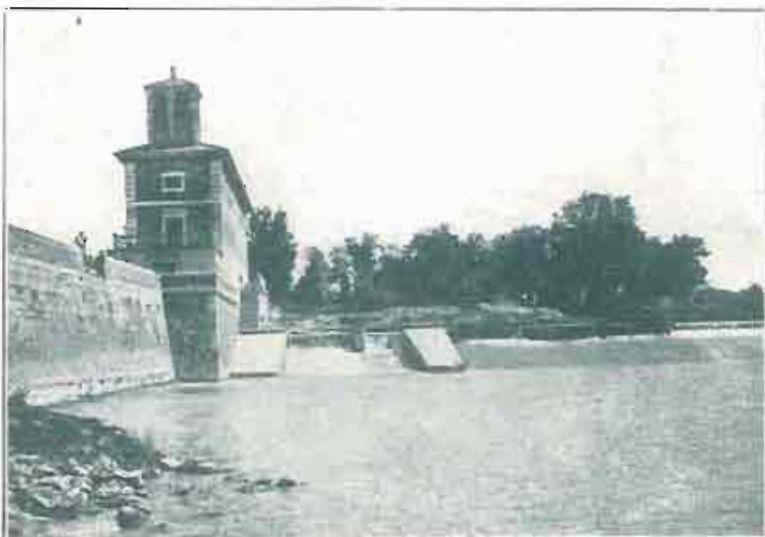
PRESA DEL CANAL IMPERIAL EN EL RÍO EBRO. « EL BOCAL »
