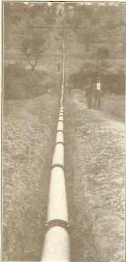
CONDUCCIÓN DE AGUAS EN CERVERA (Lérida) 1065 metros longitud. - 250 cm diámetro. - 10 atmósferas
