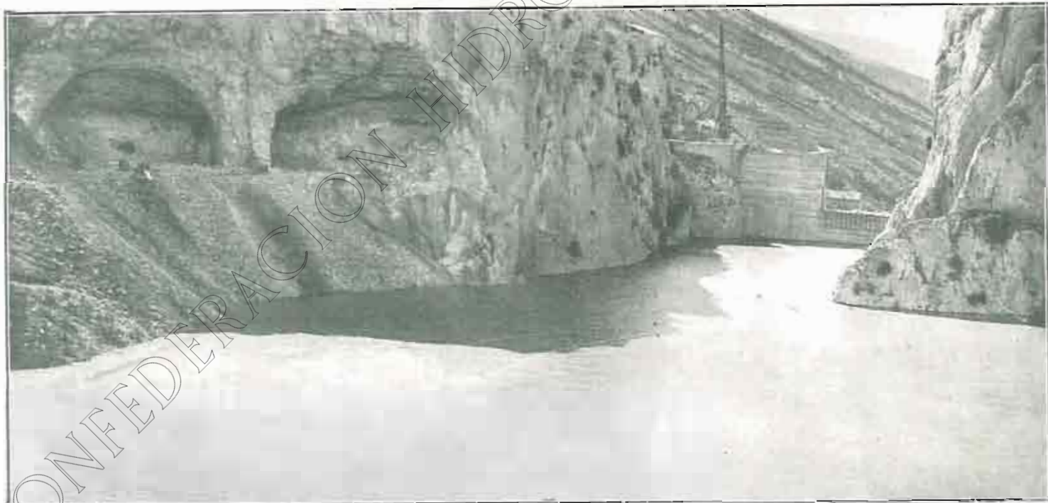
PANTANO DE BARASONA: El embalse en las inmediaciones de la presa. A la izquierda, las embocaduras del aliviadero de superficie, en construcción.
