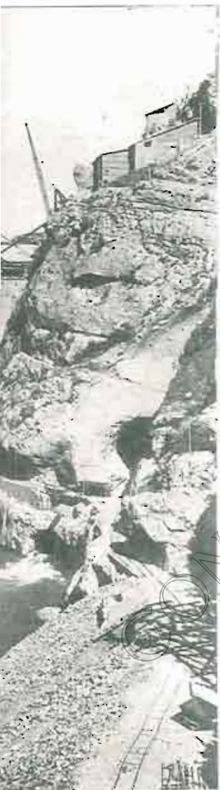
vista desde aguas abajo.
