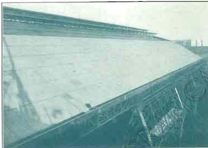
Vista de la nueva estación de H. S. A. de Barcelona, cubiertas con plaza CANALETA
