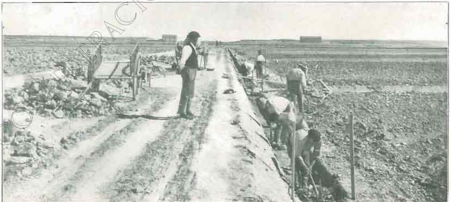
Construcción de acequias de régimen inferior.
