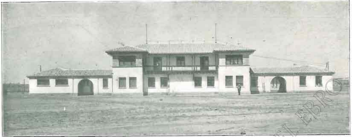
Fachada posterior de los edificios y lugar de emplazamiento de las construcciones adicionales en la Granja de Almudéva.
