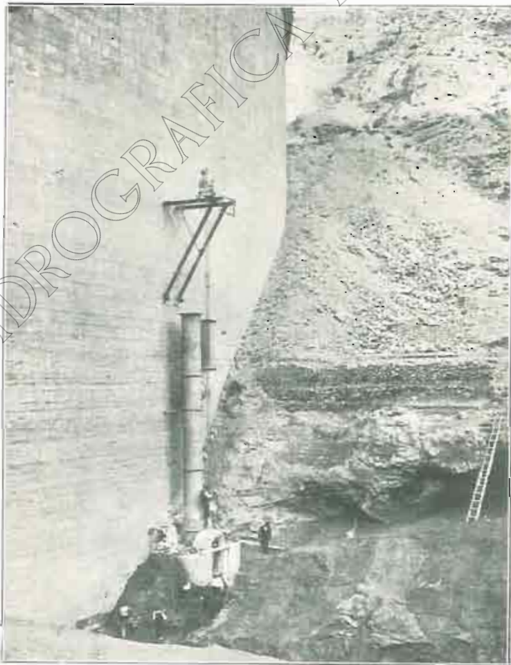
Colocación de las compuertas en el Pantano de Barasona
