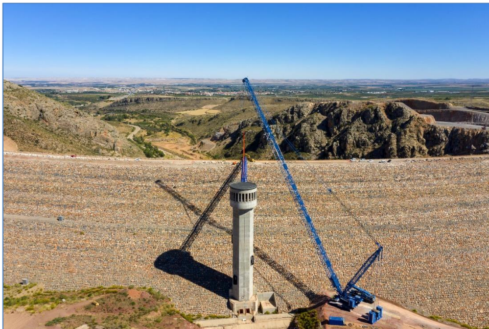
Figura 48. Vista general de la presa de Mularroya.
