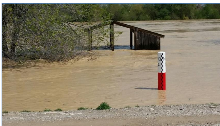
Figura 28. Crecida extraordinaria de abril 2018 en el tramo medio del Ebro. Hito en la mota defensiva de Novillas (Zaragoza).
