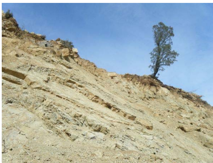
Figura 36. Detalle de la zona con las capas de mayor inclinación. Punto de lectura 75.
