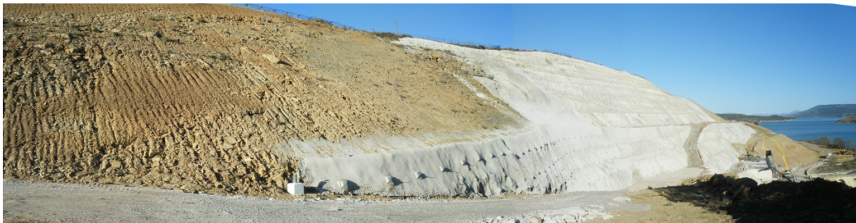
Figura 44. Panorámica de la zona al oeste de la presa donde se produce una transición de capas de bajo ángulo de buzamiento a coluvial y a la zona con el talud ya reforzado. Puntos de lectura 38 a 40
