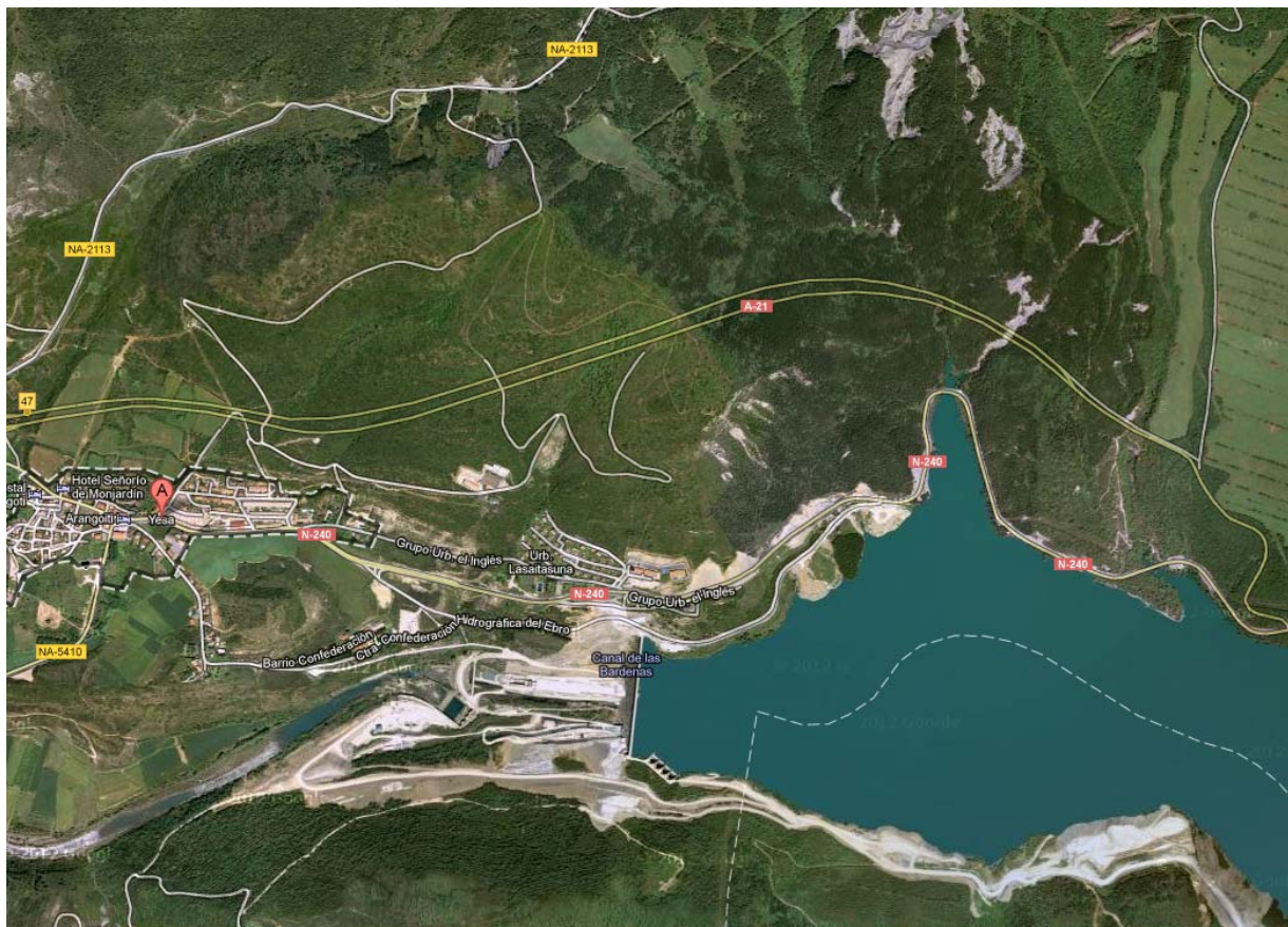
Figura 1. Planta con la situación relativa de los túneles de la A-21 (Fuente: Google Maps 2013)
