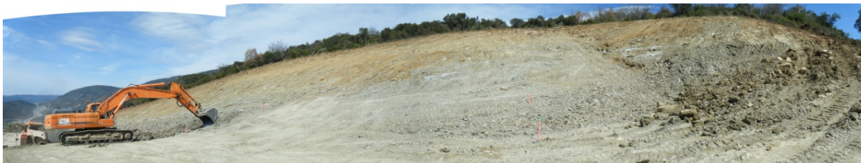
Figura 66. Excavación en la zona alta de la ladera.
