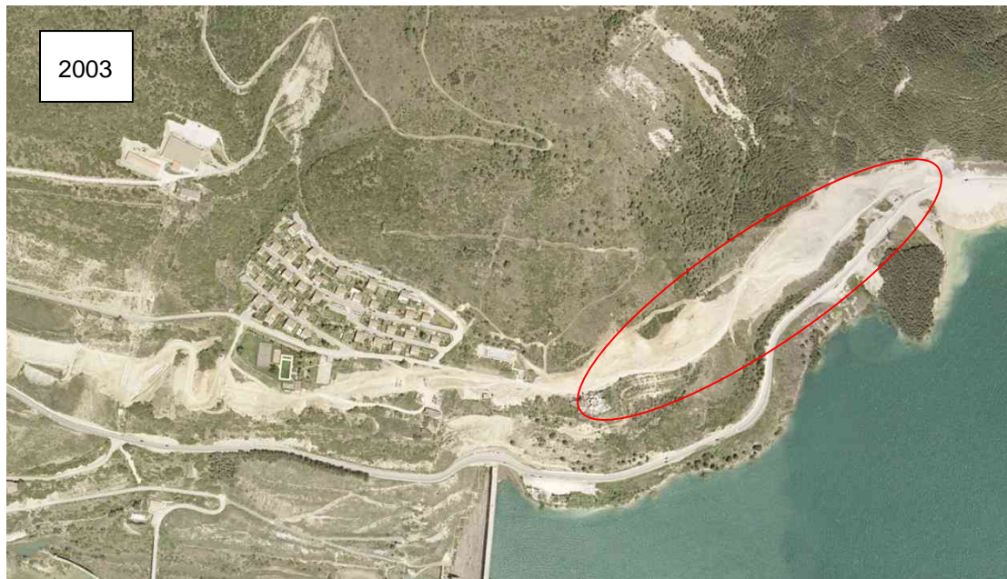
Figura 3. Se ha construido la urbanización Laisatasuna y se está ampliando la carretera con desmontes importantes. Todo esto en la zona media-baja de la zona inestable.
