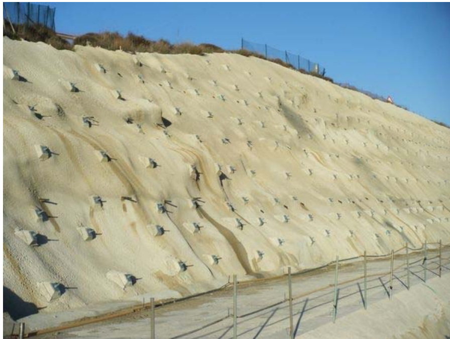
Figura 53. Detalle de uno de los taludes reforzados. Punto de lectura 42
