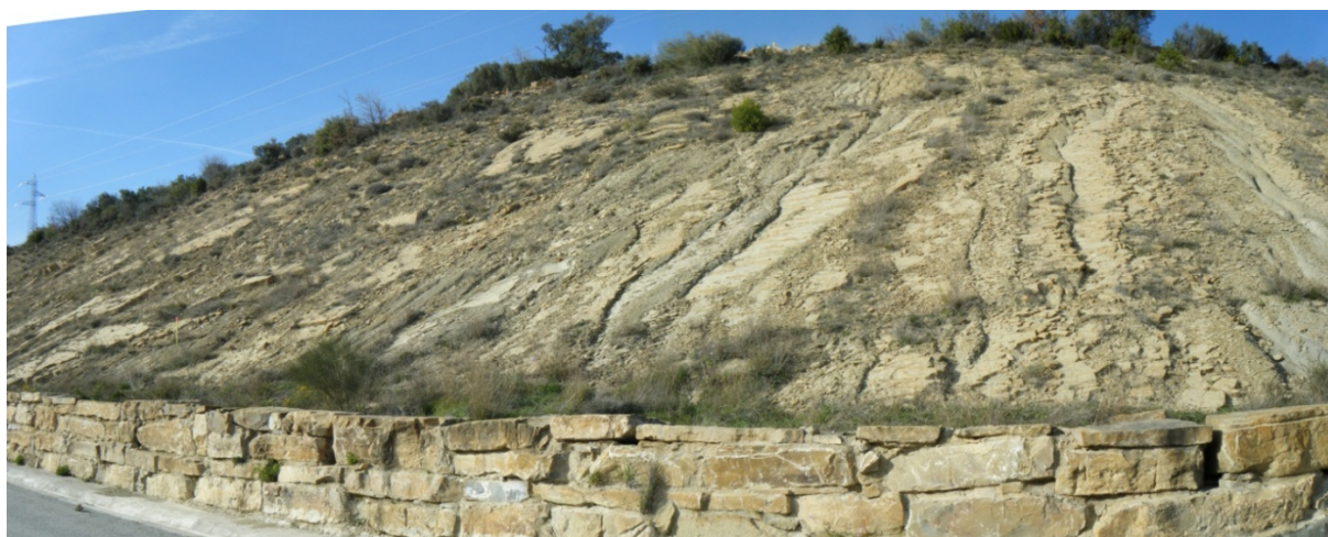
Figura 40. Capas del flysch bien estratificadas y con orientación bastante constante en el desmonte de la urbanización Mirador de Yesa. Punto de lectura 81.
