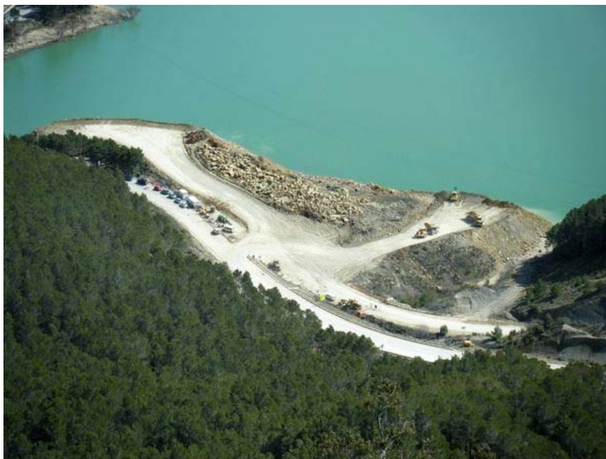
Figura 51. Relleno aguas arriba de la presa
