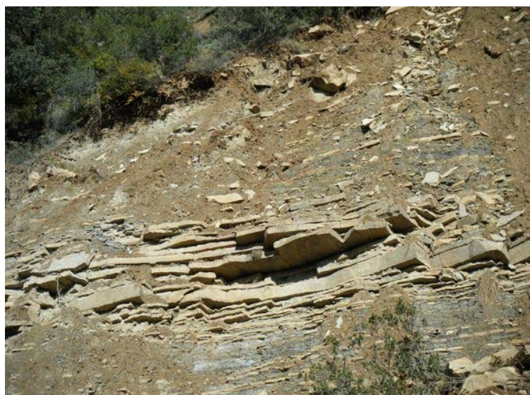
Figura 43. Detalle de la estratificación, con buzamiento hacia el interior de la ladera
