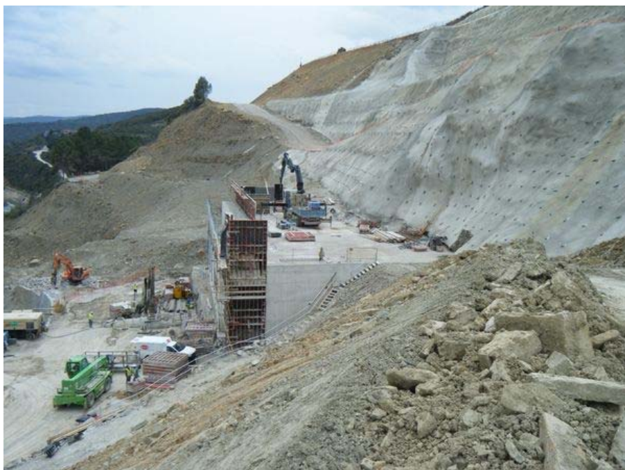
Figura 14. Construcción bloque estructura de contención.
