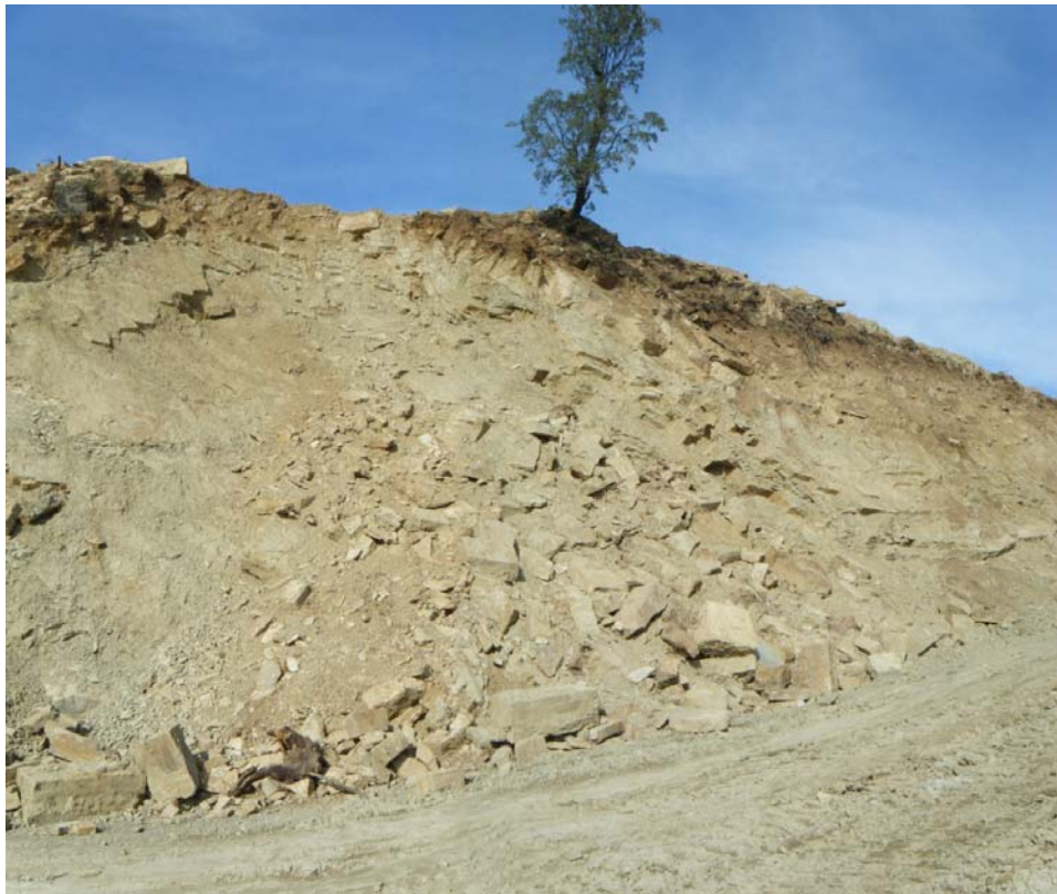
Figura 164. Ejemplo de un deslizamiento translacional de bloques reciente, de pequeña extensión, producido a favor de la estratificación en la zona media de la ladera. El talud tiene pocos días. Nótese la acumulación de bloques que se produce en el pie. A mayor escala constituyen depósitos similares a los descritos como coluvial con bloques (Q3). Punto de lectura 75.
