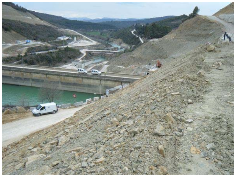
Figura 50. Relleno en la zona baja del lado Este de la ladera
