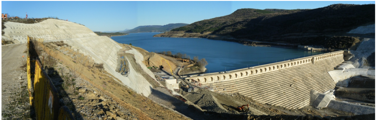
Figura 24. Panorámica de la presa y de la zona excavada para el recerimiento y con taludes en parte reforzados con anclajes y hormigón proyectado.
