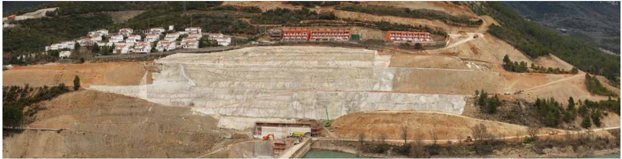
Figura 23. Panorámica de los muros y las excavaciones realizadas para las obras de recerimiento.
