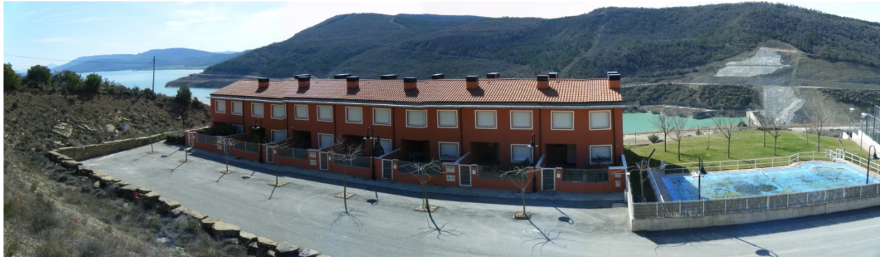
Figura 15. Panorámica de las edificaciones de la urbanización Mirador de Yesa.
