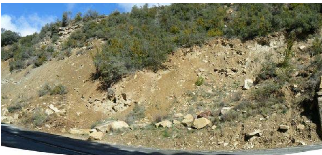
Figura 47. Depósito de coluvial con bloques
