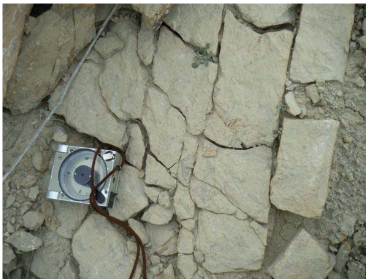
Figura 33. Detalle de la apertura entre bloques de las capas de areniscas
