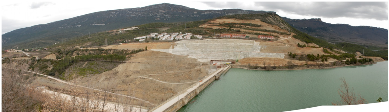
Figura 7. Panorámica general de la margen derecha
