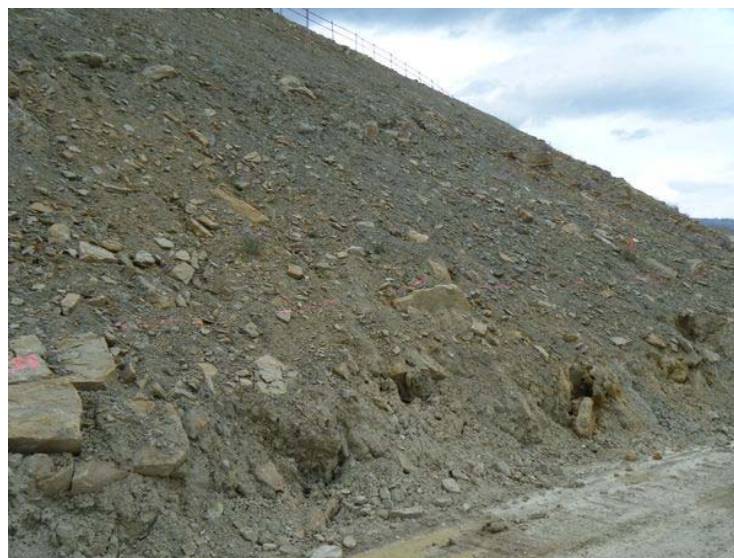
Figura 77. Detalle del afloramiento en la zona con posible decompresión y deformación del macizo rocoso. Punto de lectura 123.
