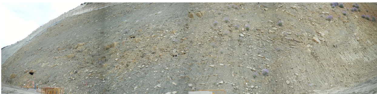
Figura 45. Panorámica de la zona al Este de la presa. Pliegue suave y falla. Nótese que las capas están bastante rotas ya que es la zona con mayor movimiento registrado. Punto de lectura 121
