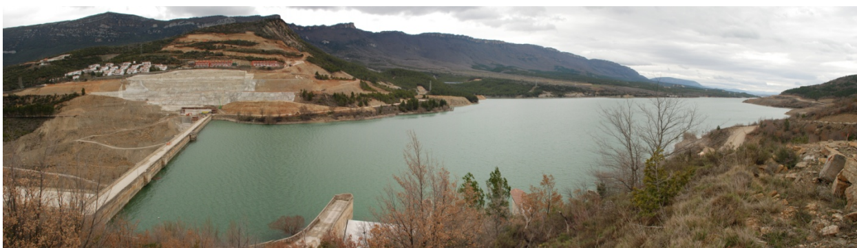
Figura 9. Panorámica general de la presa y embalse de Yesa
