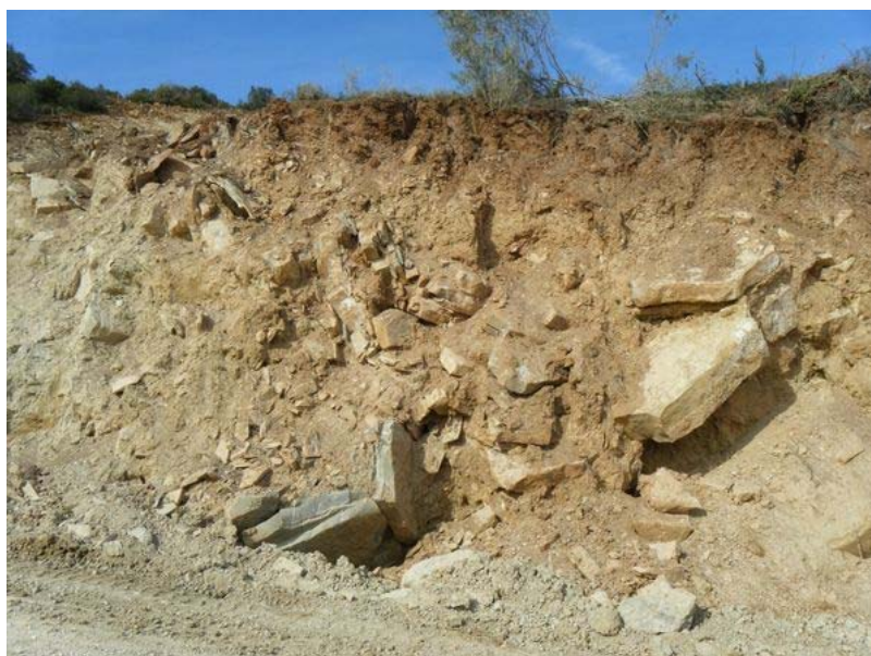
Figura 39. Transición entre zona de falla y acumulación de bloques. Punto de lectura 72.
