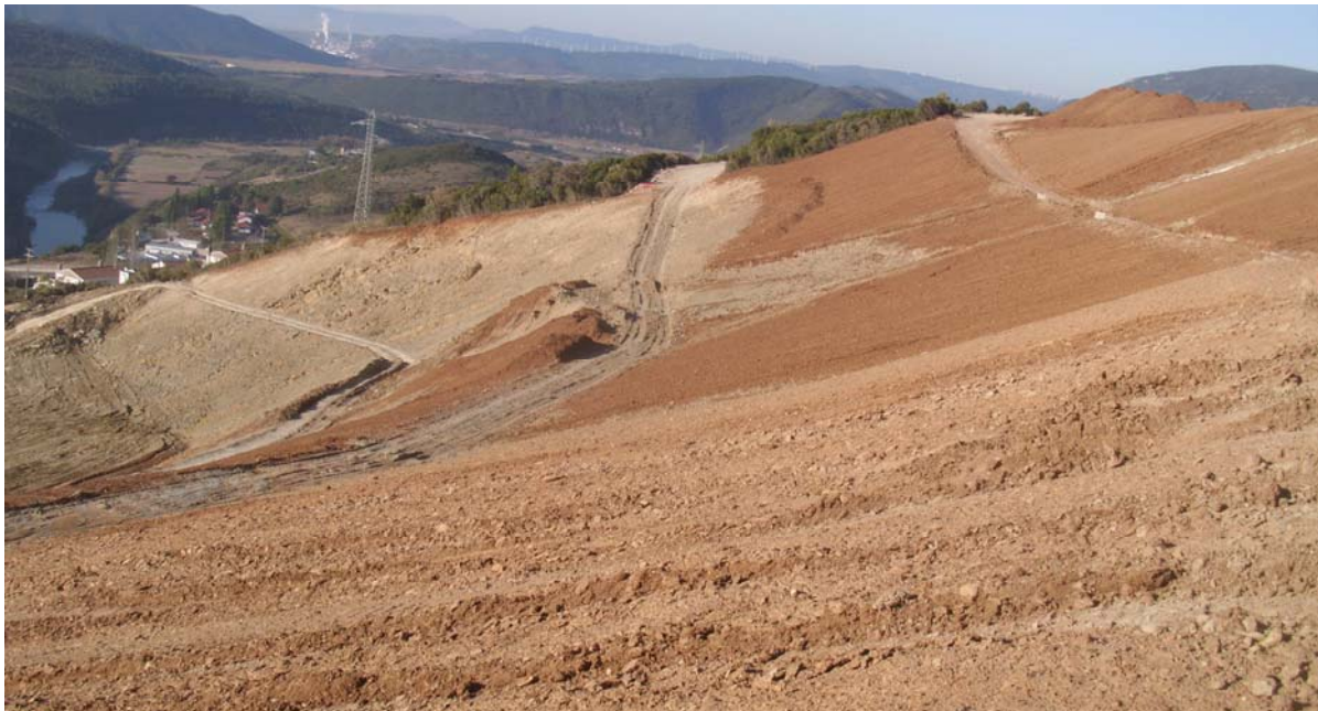
Figura 3.47: Vista hacia el Oeste donde se observa en el centro de la imagen la berma nº 3, así como los bancos nº 3 y nº 4.
