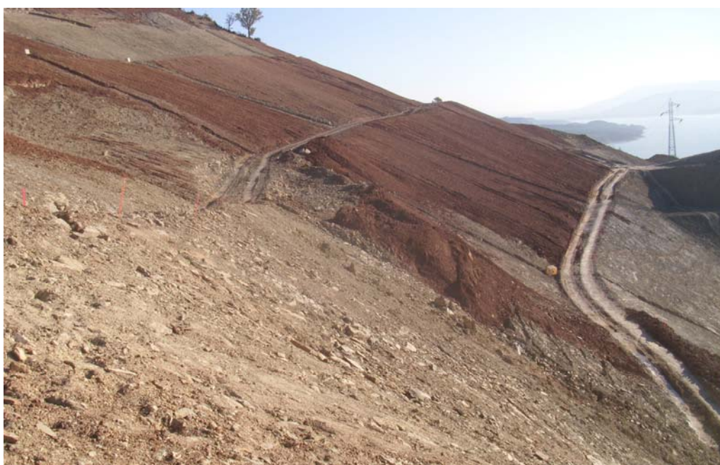
Figura 3.50: Vista de las bermas nº 2 y nº 3 hacia el E, donde se observa el alcance completo del deslizamiento superficial.
