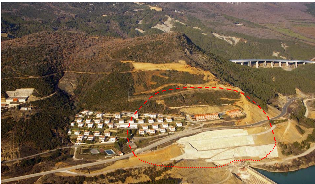
Figura 3.2: Vista aérea de la ladera derecha de la cerrada del embalse de Yesa en la que se muestra el alcance aproximado de la masa inestable estudiada, delimitada por la superficie principal de rotura SPR. Se observa el inicio de las actuaciones que se estaban llevando a cabo para su estabilización, cuando estas se encontraban en sus fases iniciales: eliminación de peso en coronación y aplicación de una masa estabilizadora al pie (Foto tomada de www.yesano.com , autor Miguel Santamaría).
