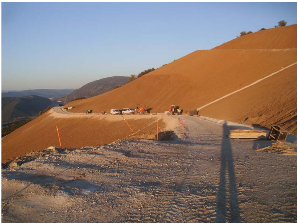
Figura 3.40: Vista hacia el Oeste de la berma nº 6 y los bancos nº 6, nº 7 y nº 8.
