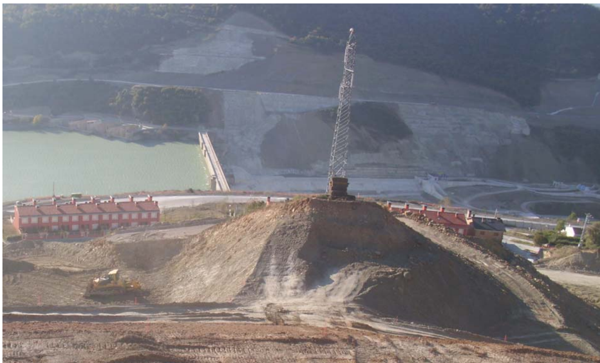
Figura 3.48: Vista de la masa de 90.000 m 3 de terreno situada al pie de la excavación, pendiente de ser eliminada una vez sea trasladada la torre eléctrica.
