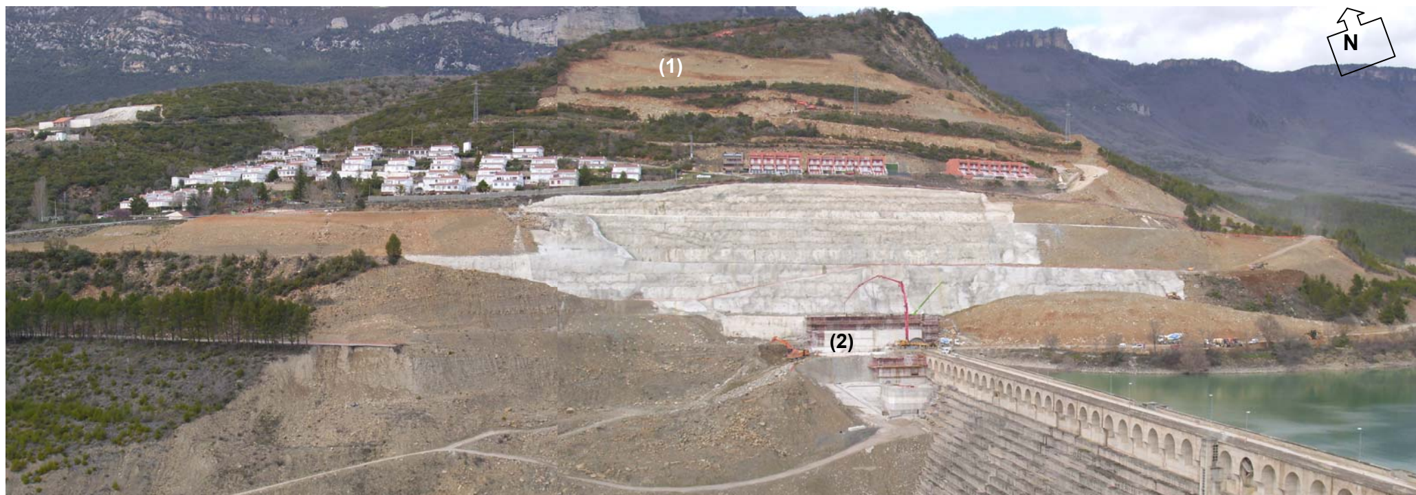
Figura 3.34: Vista de la ladera derecha de la cerrada del embalse de Yesa desde la margen izquierda (junio de 2013). Se observaba el progreso de la excavación de la parte alta de la ladera (1) y la ejecución de los muros-jardinera al pie, en el entorno del estribo derecho de la presa actual y del sector entre presas (2).
