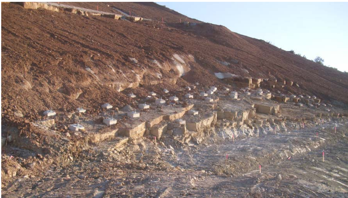
Figura 3.43: Detalle de la estabilización del deslizamiento local que tuvo lugar en la berma nº 5 mediante el cosido de los estratos con bulones de barra de acero.
