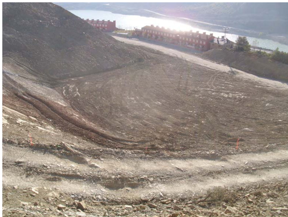
Figura 3.54: Vista del fondo de la excavación situado aguas arriba de las Urbanizaciones Lasaitasuna y Mirador de Yesa. Se observa la plataforma resultante de grandes dimensiones que ha permitido la eliminación de toda la parte superior de la masa afectada por la SPR y una gran descarga de la cabecera de la masa afectada por la SIR.
