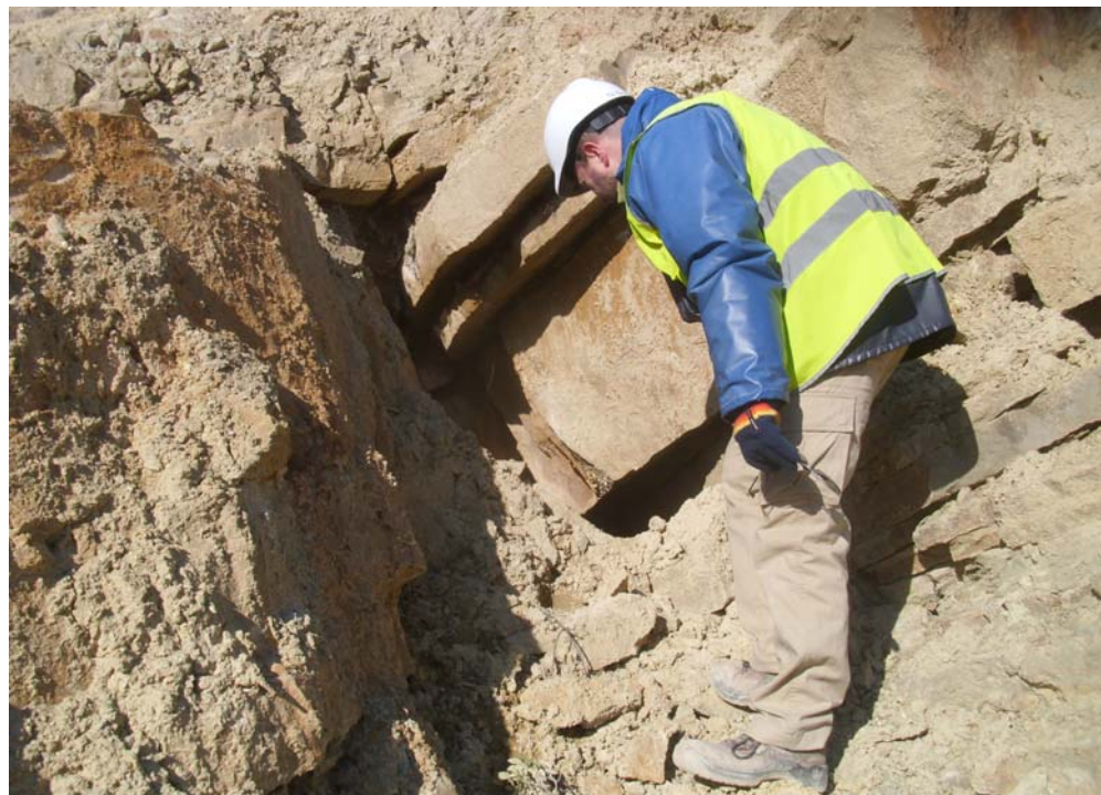
Figura 3.51: Entrada a una cavidad de tamaño métrico generada en el límite Oeste de la masa inestable delimitada por las superficies de rotura SPR y SIR.
