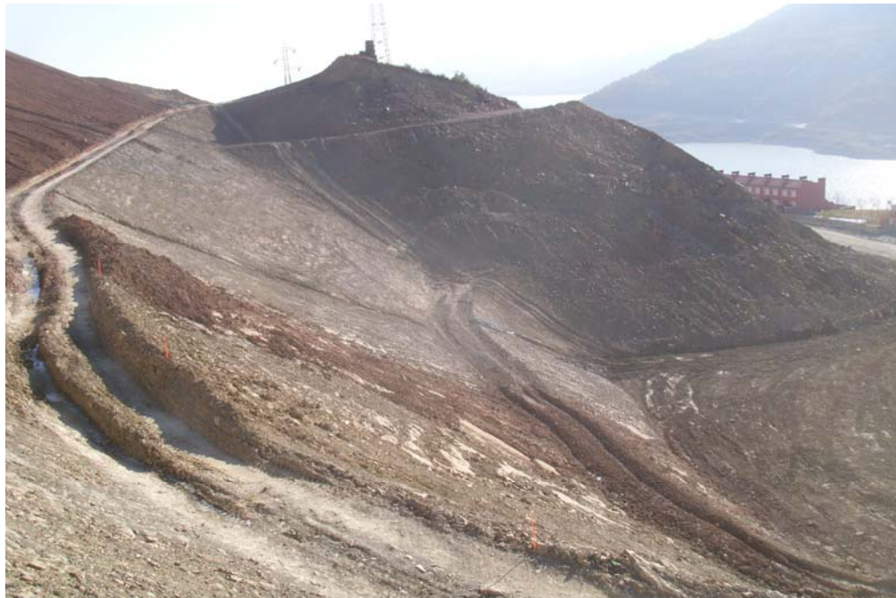
Figura 3.53: Vista de las bermas nº 1 y nº 2 hacia el E. Se observa el fondo de la excavación y los bancos nº 1 y nº 2. Puede verse la masa de terreno de 90.000 m 3 pendiente de ser retirada cuando se traslade la torre eléctrica.
