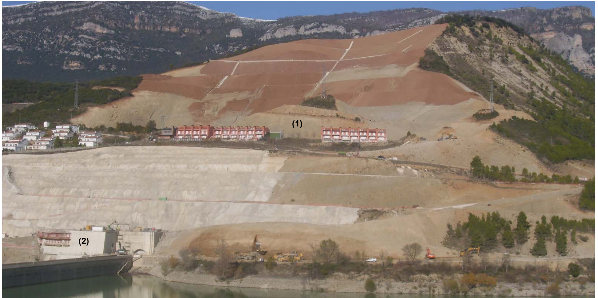
Figura 3.35: Vista general de la ladera a fecha 28/11/2013 desde la ladera contraria. La excavación estaba prácticamente finalizada a falta de retirar unos 90.000 m 3 tras la Urbanización Mirador de Yesa, pendientes del traslado de una torre eléctrica (1). Se observa también el progreso de la ejecución de los muros-jardinera, que aportan peso estabilizador al pie y permiten la impermeabilización de la ladera entre la presa actual y la nueva presa (2).
