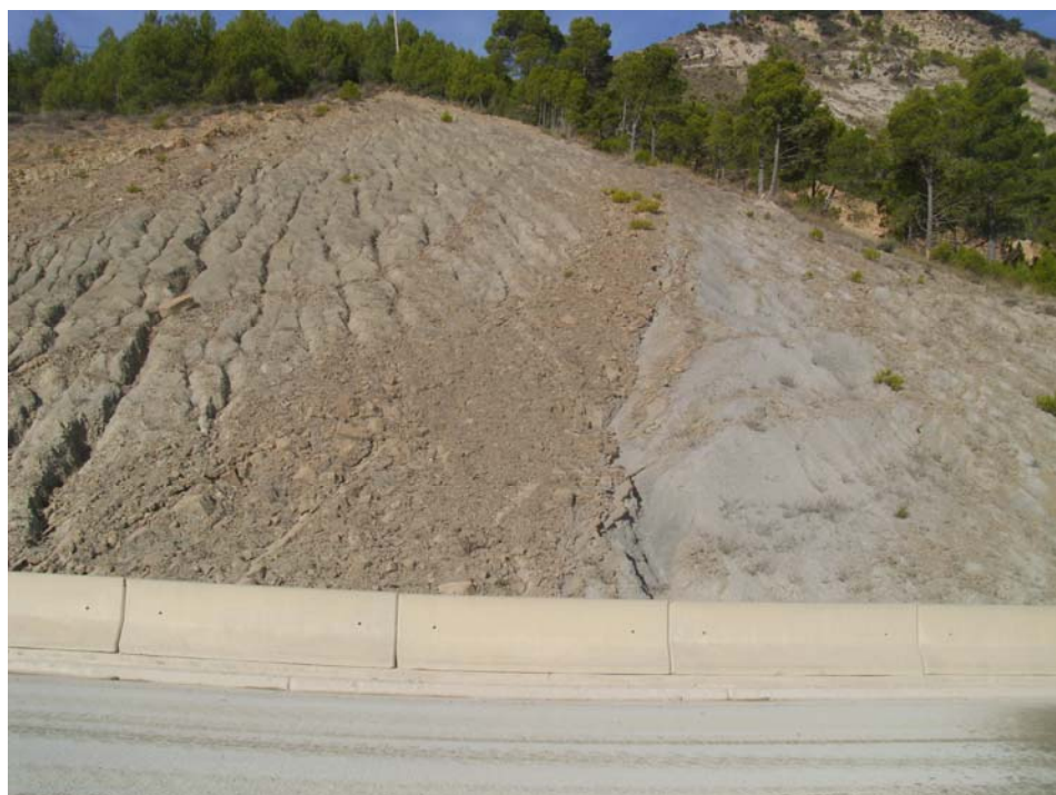
Figura 3.9: Avanzando unos 120 m a lo largo del talud de la carretera N-240 se observa el límite E de la superficie inferior de rotura SIR, ya inmerso en las proximidades del contacto Flysch de Yesa – Margas de Pamplona, donde predominan los paquetes margosos de espesor métrico y la presencia de niveles de arenisca es claramente minoritaria
