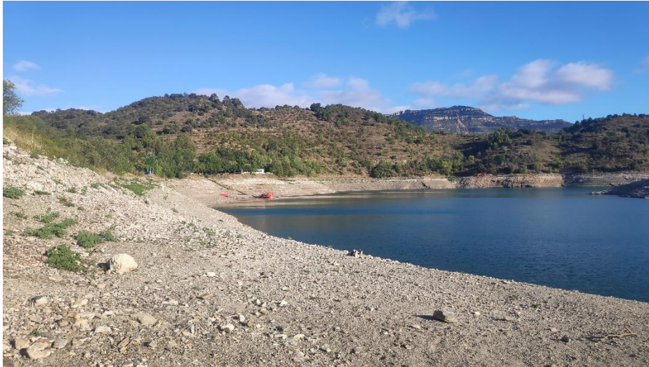
Figura 66 Vista de una de las orillas de la presa.
